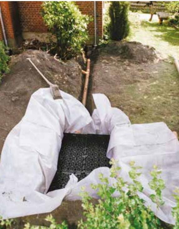
**Wavin AquaCell Lite kan installeres parallelt eller i serie i forhold til rørledningen. Ved installation gælder følgende:**
