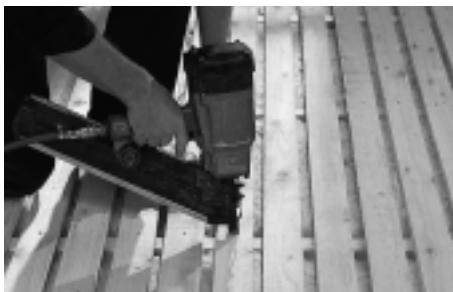
Dernæst monteres varmefordelingsplader på forskallingsbrædderne i henhold til monteringsskitten. Søm kun varmefordelingspladerne fast i den ene side af pladen. Der bruges fx 2,5x20 mm pappsom pr. 20 cm.
