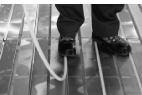
Hvor rørene vendes, skal de monteres under forskallingsbrædderne. Efter trykprøving af installationen, lægges overgolv i henhold til gulvproducentens anvisninger. Af hensyn til trinlyd er det vigtigt at have et lydabsorberende materiale, f. eks. gulvpap mellem varmefordelingsplader og overgolv. Husk evt. frostskrинг.
