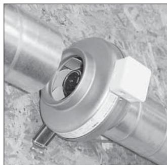
2. Rohre und Ventilator zusammensetzen.
